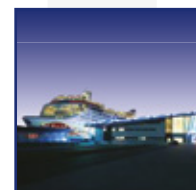
Центр управления моским портом
