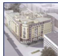
Жилой комплекс «Пионерская»
